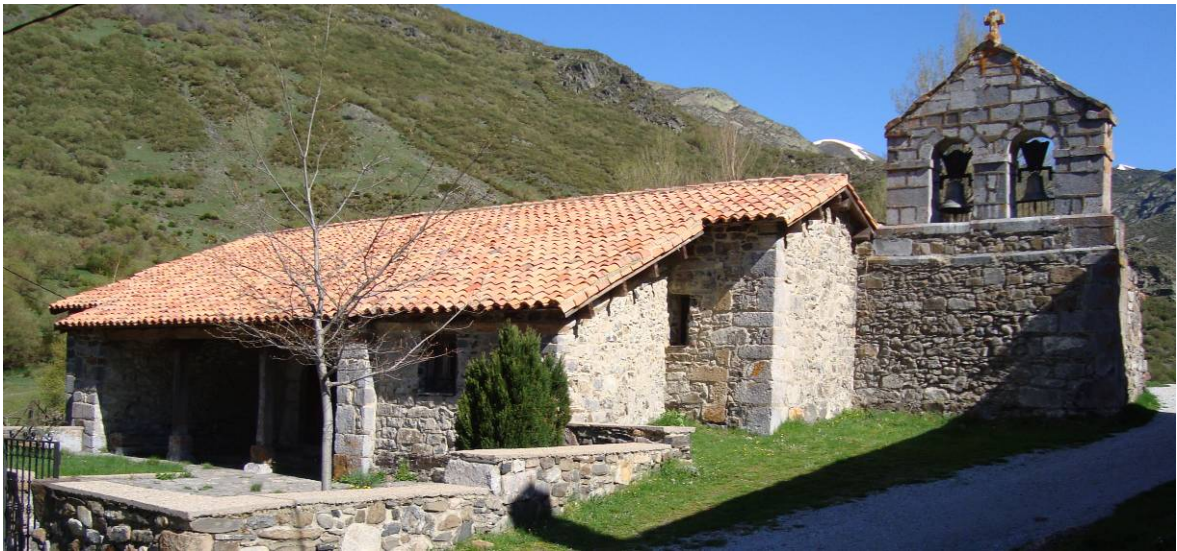
Figura 49. Patrimonio arquitectónico. Iglesia de San Lorenzo. Cardaño de Arriba.
