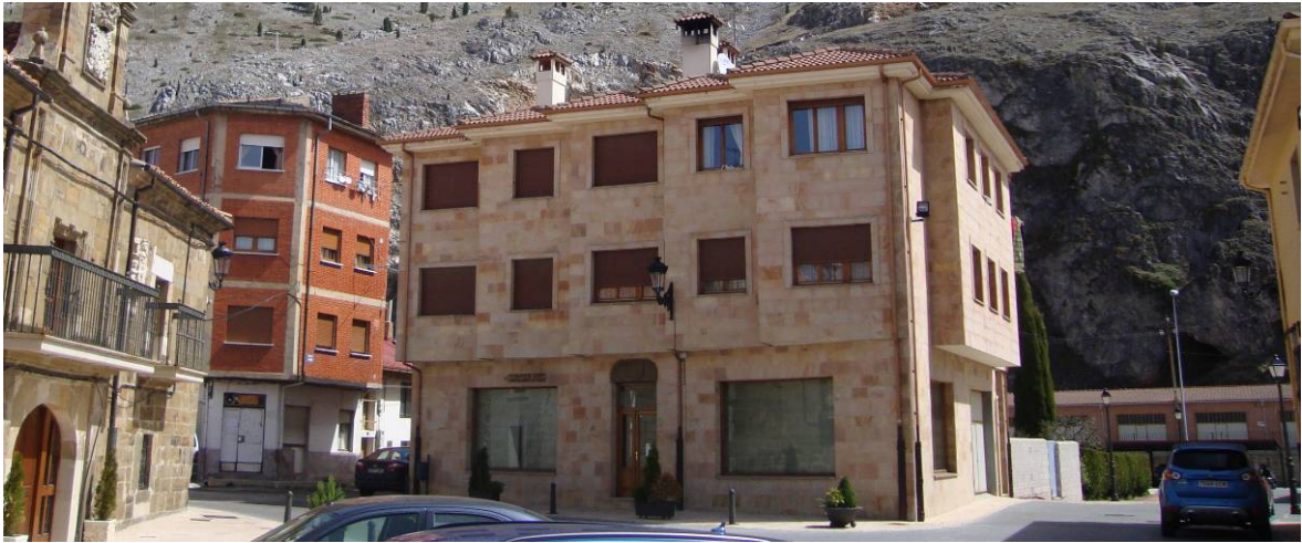
Figura 170. Edificio de vivienda colectiva en el casco tradicional de Velilla del Río Carrion
