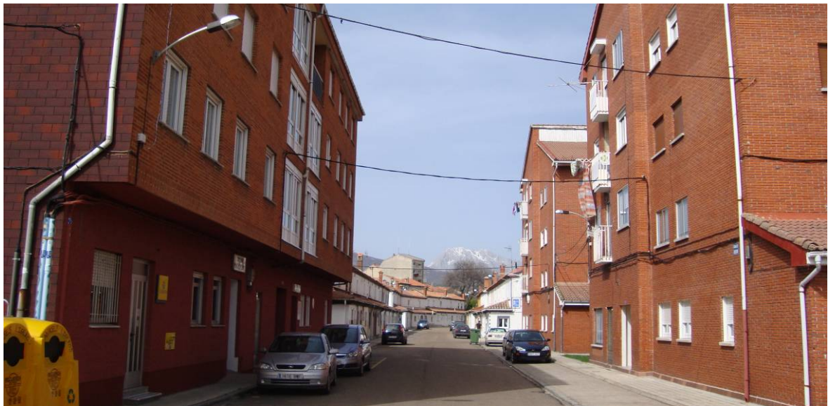
Figura 167. Edificios de vivienda colectiva construidos en los años ochenta en la zona sur del casco urbano de Velilla.
