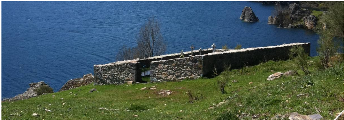
Figura 157. Cementerio de Alba de los Cardaños junto al pantano de Camporredondo (Barrio del Castro).
