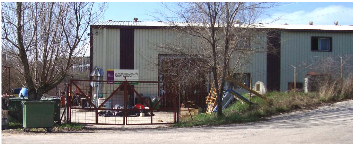
Figura 61. Estación Depuradora de Aguas Residuales (E.D.A.R.). Velilla del Río Carrión.
