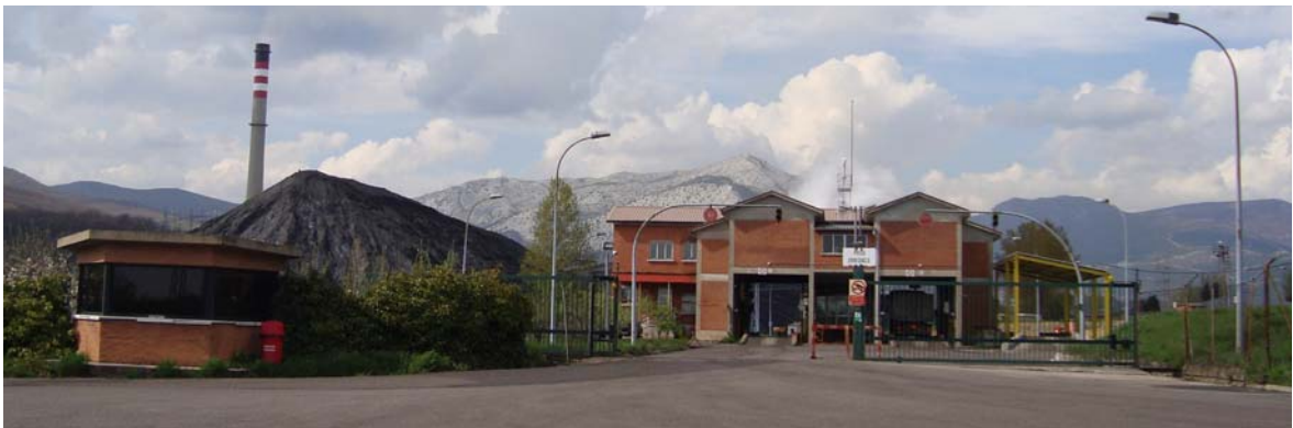
Figura 141. Usos industriales. Central Térmica en Velilla del Río Carrion
