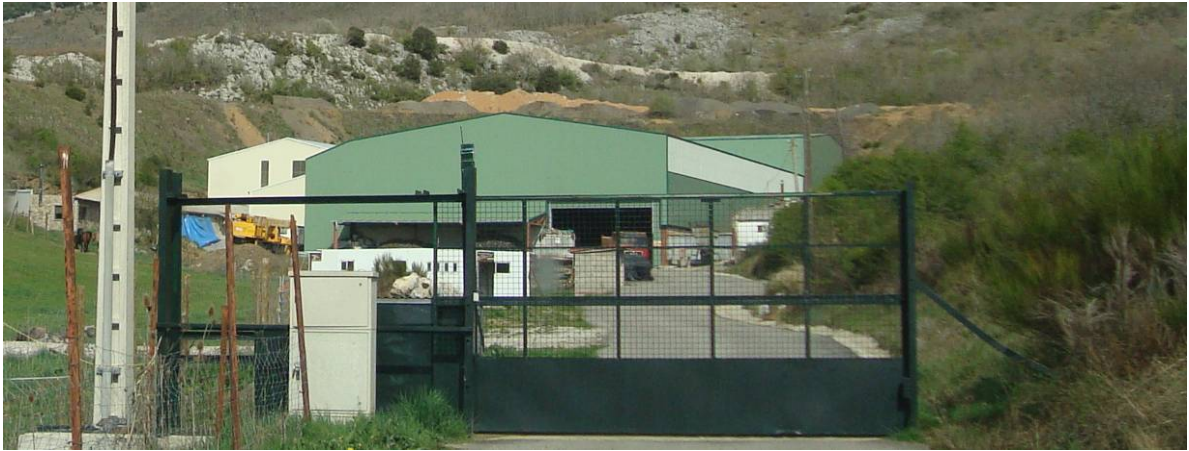
Figura 173. Actividades productivas de extracción de áridos en Velilla del Río Carrion.
